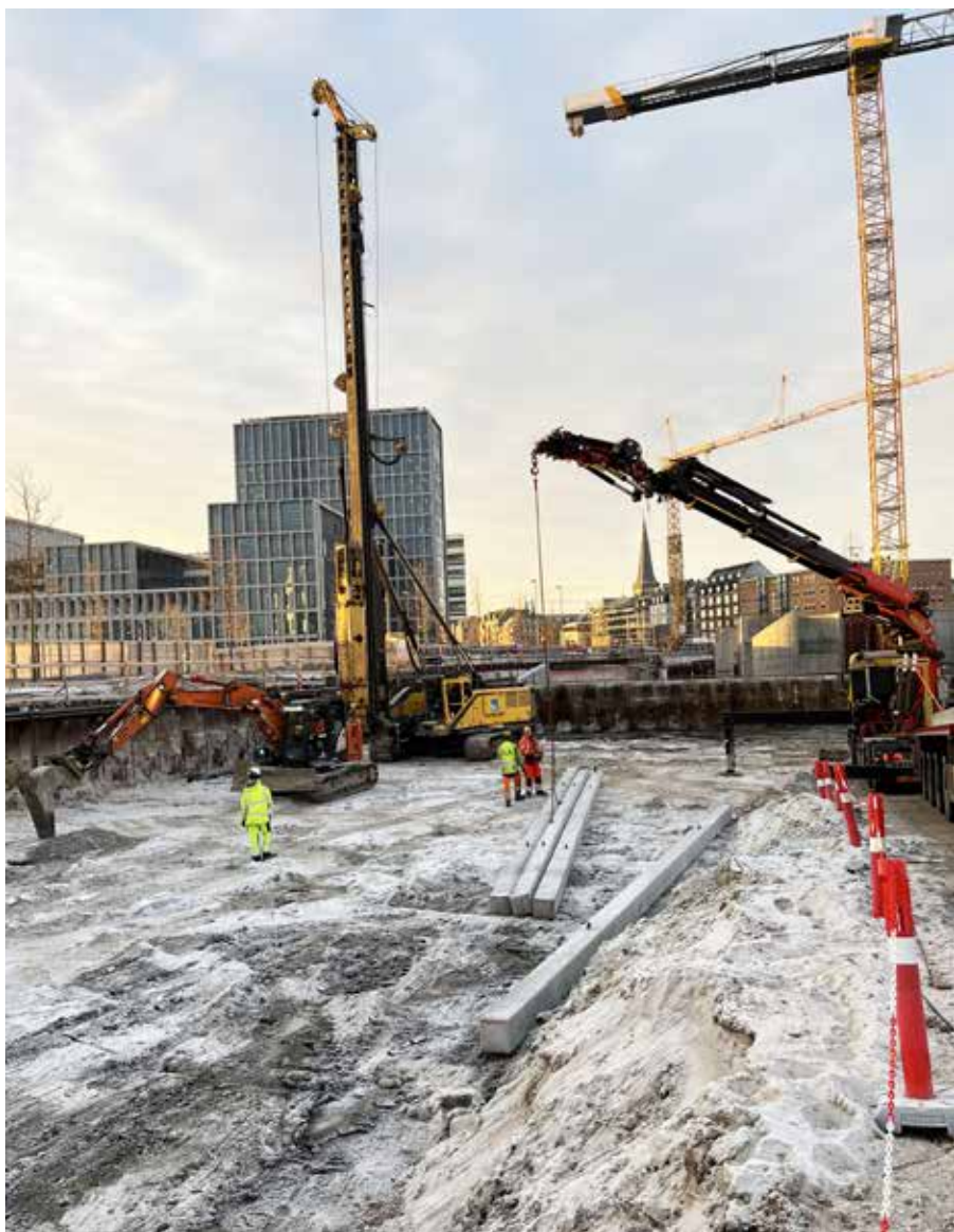
Spuns er nedsat og pælefundering stikker op. Efterfølgende synliggøres stål i pillerne, der bindes sammen, hvorefter der støbes et stort betondæk.
