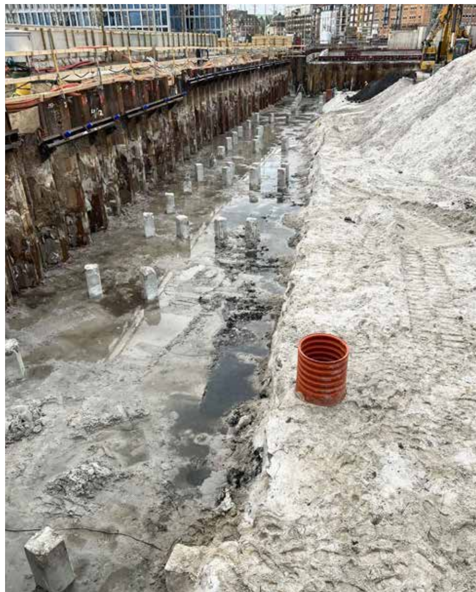
Spuns er nedsat og pælefundering stikker op. Efterfølgende synliggøres stål i pillerne, der bindes sammen, hvorefter der støbes et stort betondæk.
