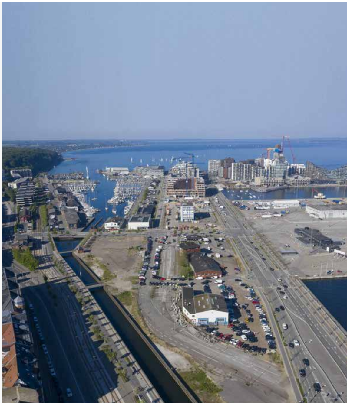
Oversigtsbillede af Mejlbryggen før byggestart.
