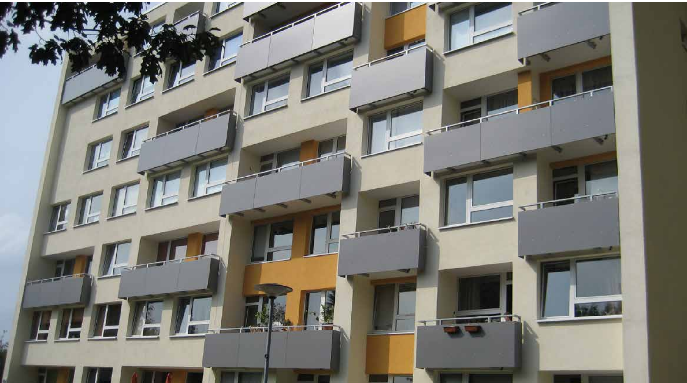
Brandenbaumer Feld i Lübeck efter facaderenovering.
